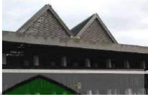
Gambar 4.4 Kisi-kisi sebagai ventilasi (sumber: banyuwangibagus.com)
